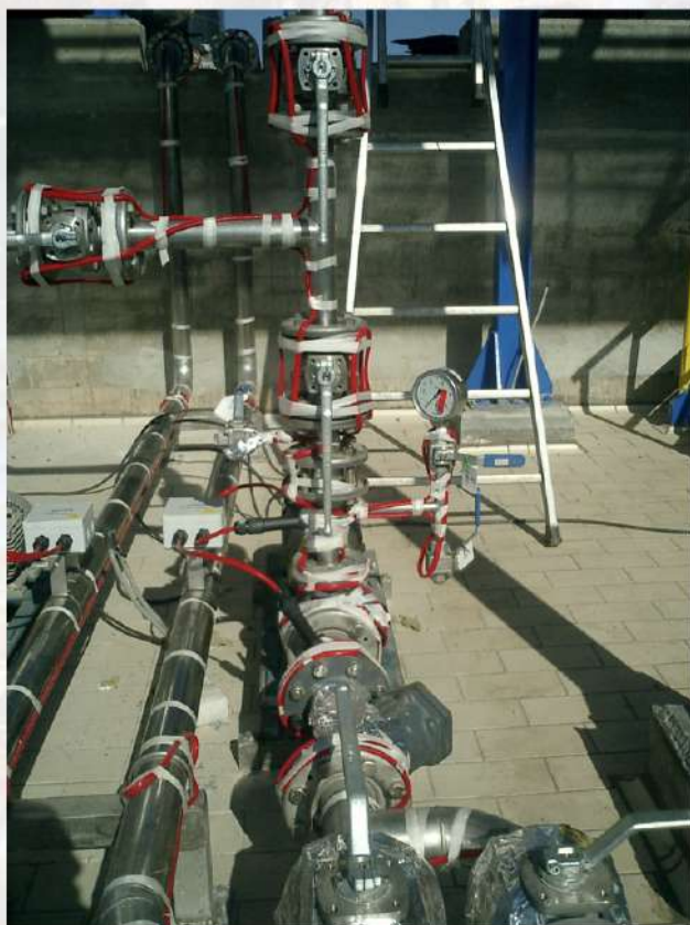
SERVIÇO DE INSTALAÇÃO
